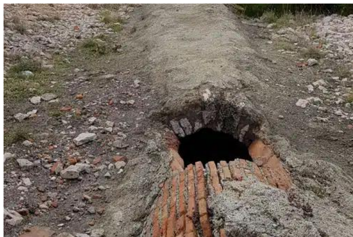
Etat initial avant travaux
