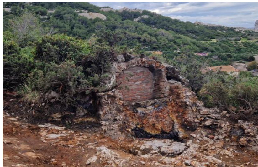
En cours de travaux
