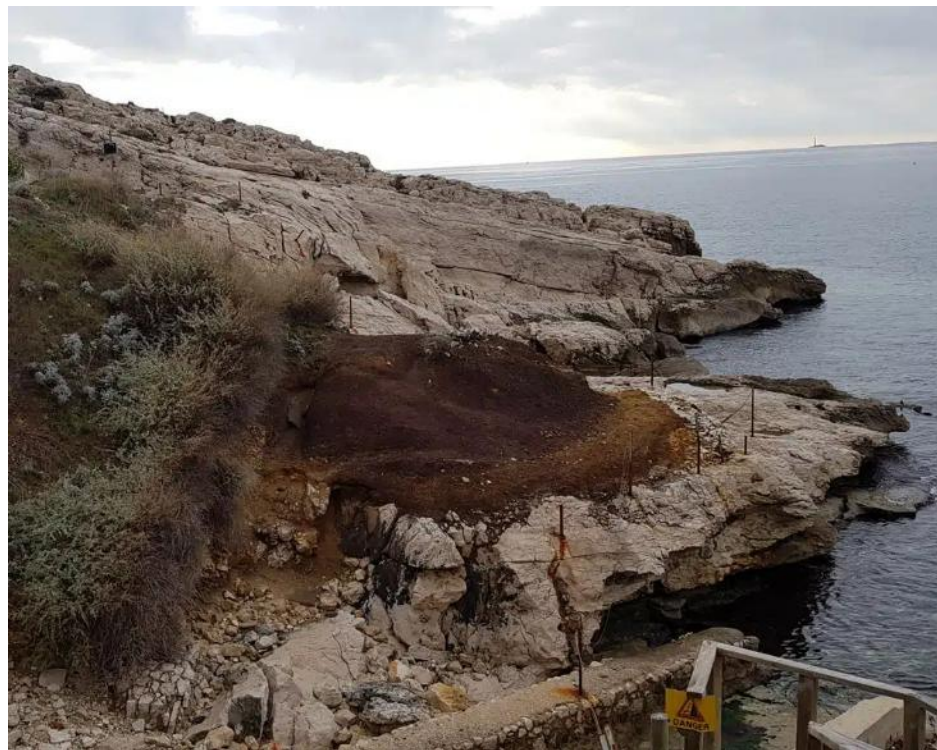
Etat initial avant travaux
