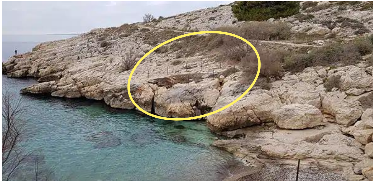
Etat initial avant travaux
