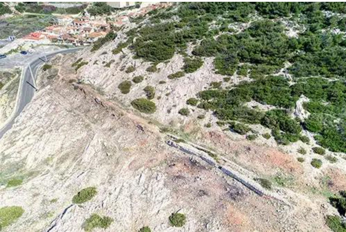
Etat initial avant travaux
